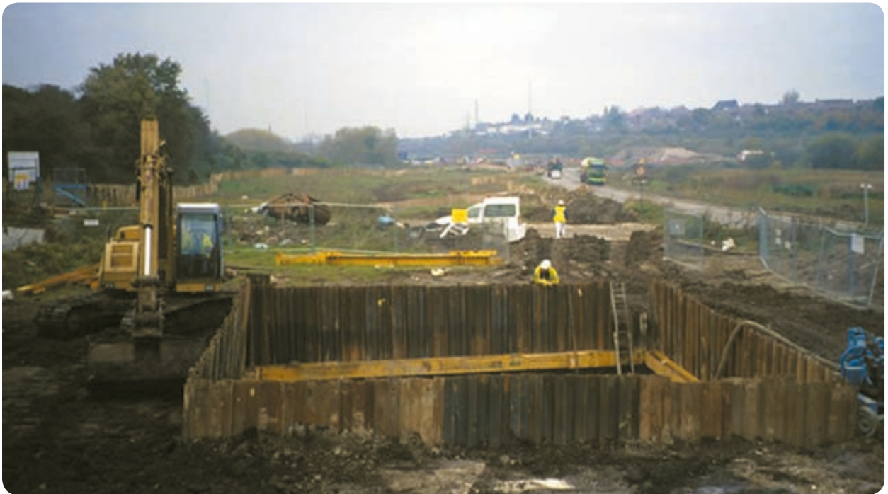
EXCAVACIÓN POR COMPARTIMENTOS
