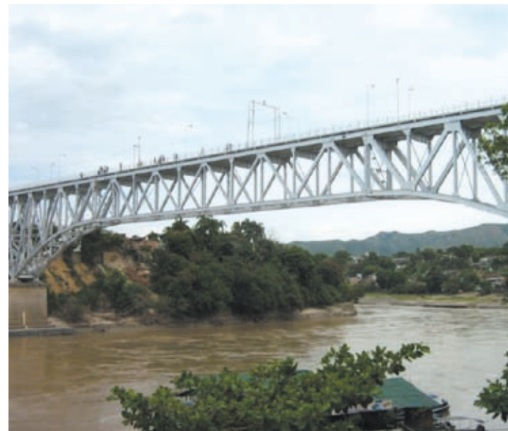
FIGURA 1. PUENTE DE LA VARIANTE, SOBRE EL RÍO MAGDALENA
